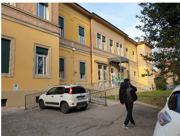
Ingresso in uso, considerato principale
